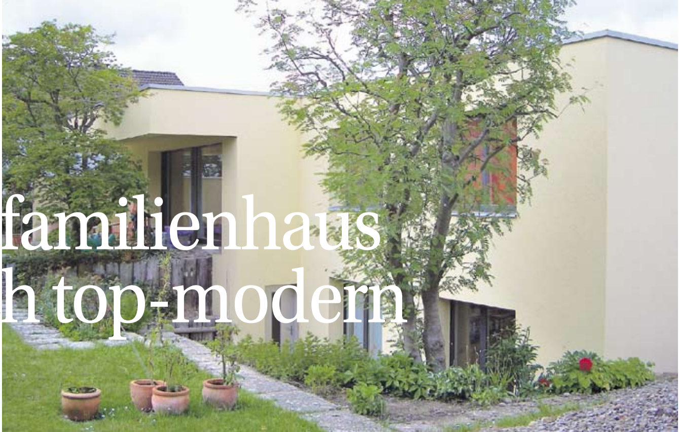
Oben: Das nach MINERGIE® modernisierte Einfamilienhaus der Familie Frei-Hardt in Staufen, AG.
