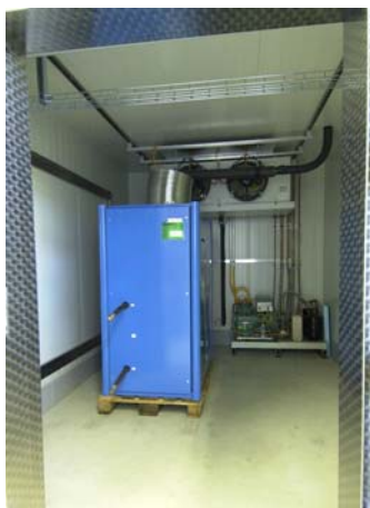
Wärmepumpe in der Klimazelle im Wärmepumpen Prüf- und Testzentrum, Buchs.
