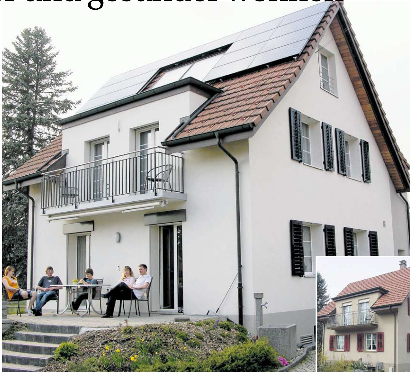
Das Einfamilienhaus der Familie Bhend in Oftringen AG vor (kleines Bild) und nach der Modernisierung nach MINERGIE. Die Solarpanels auf dem Dach produzieren rund 60% des Warmwasserbedarfs und den Strom für den Betrieb der Wärmepumpe.
