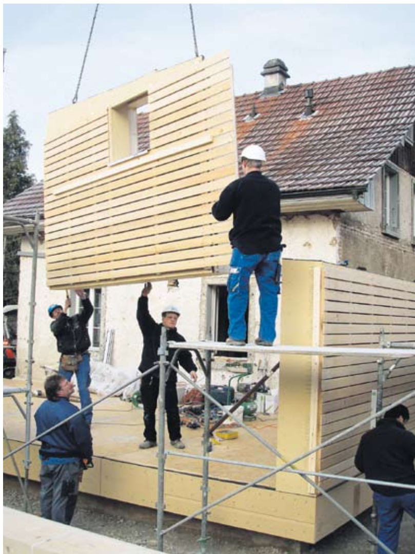
Der Anbau in Holzmodulbauweise wird auf ein Fundament aus Recyclingbeton gestellt.
