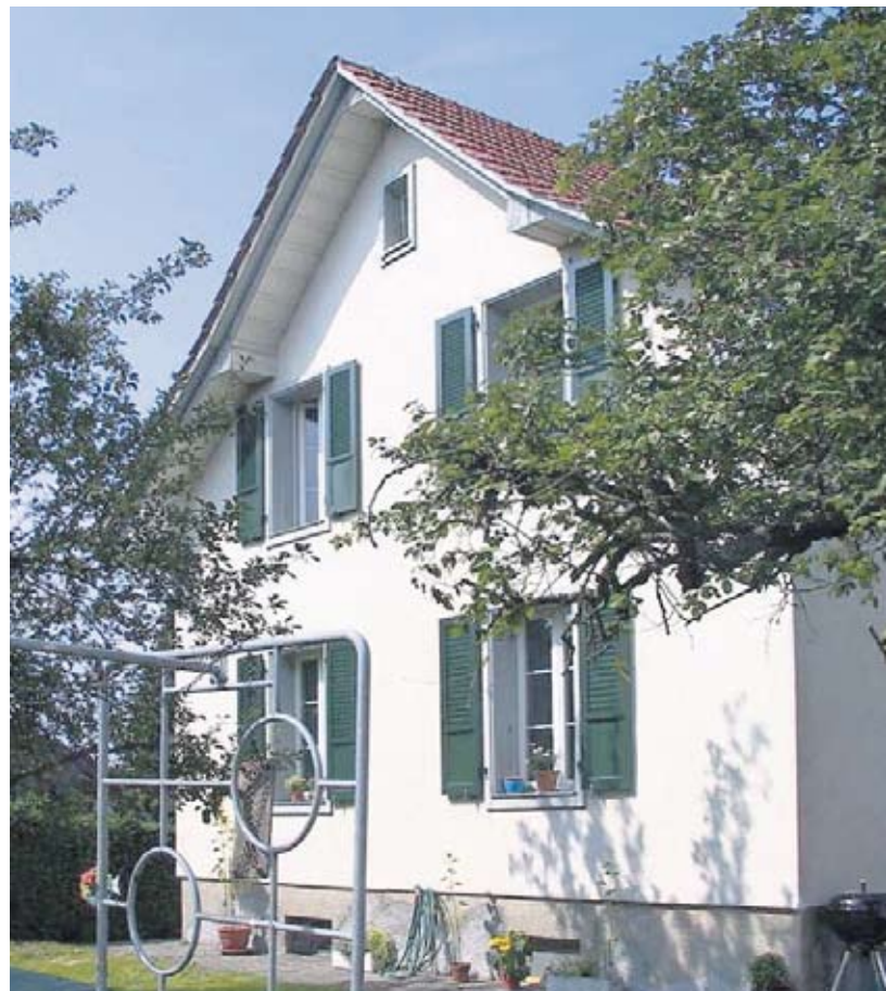
Das Einfamilienhaus vor der Modernisierung nach MINERGIE-P®.
