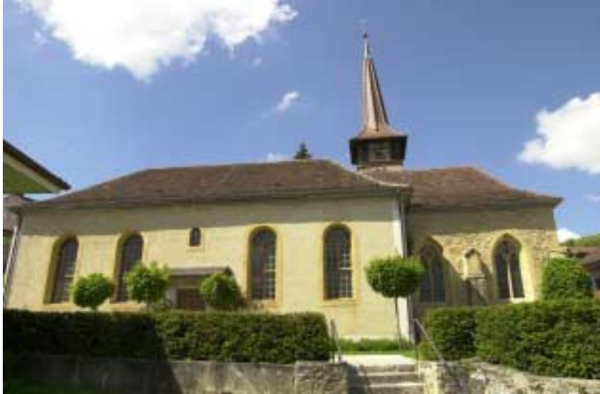
Die reformierte Kirche in Môtier, deren Chor aus dem 16. Jahrhundert stammt, wird mit modernster Technik beheizt: einer Erdsonden-Wärmepumpenheizung.
