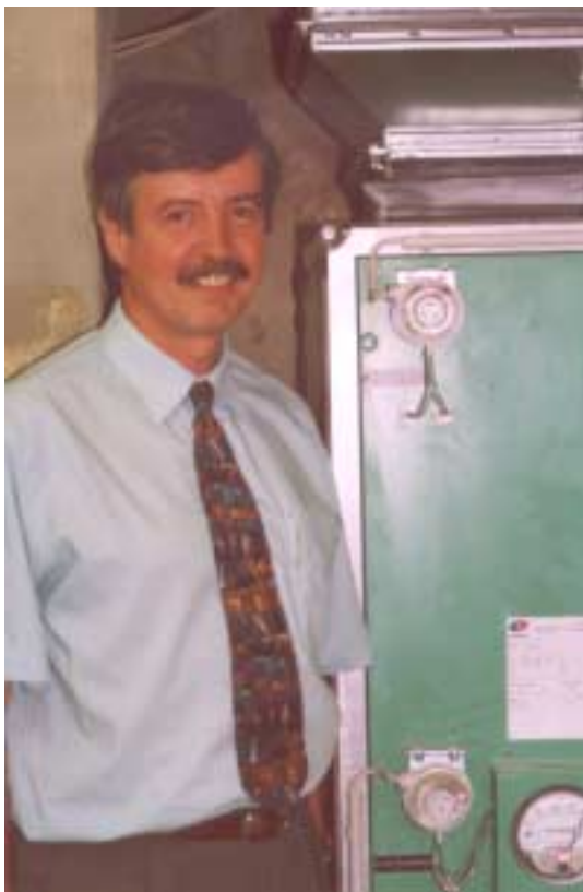
Brian Coleman war als Vizepräsident der Kirchgemeinde für die Heizungssanierung verantwortlich. Hier steht er in dem nur gerade 8 m 2 grossen Heizraum vor der Wärmepumpe. Rechts oben der Luftkanal für die Wärmeverteilung in der Kirche.
