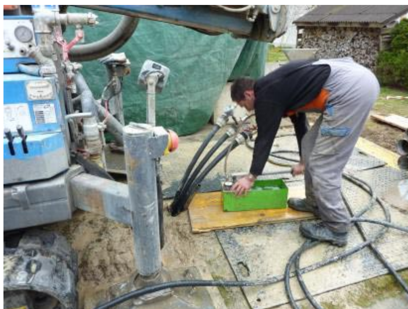
Bildquelle: FWS/SP: Druckprüfung der abgeteuften Erdwärmesonde
