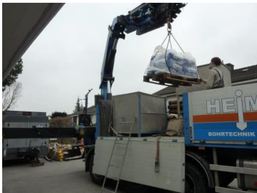
Bildquelle: FWS/SP: Ablad des Hinterfüllmaterials
