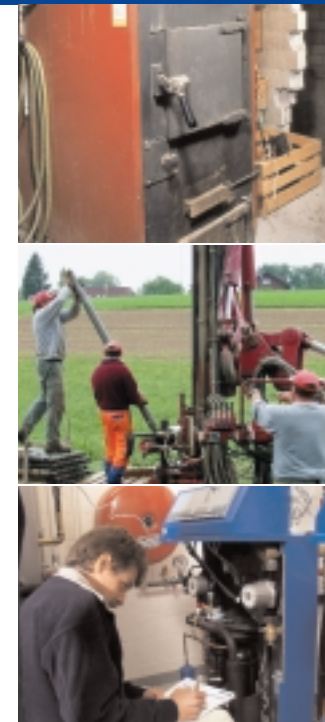
Bild 1: Die bestehende Holzfeuerung wurde demontiert.
