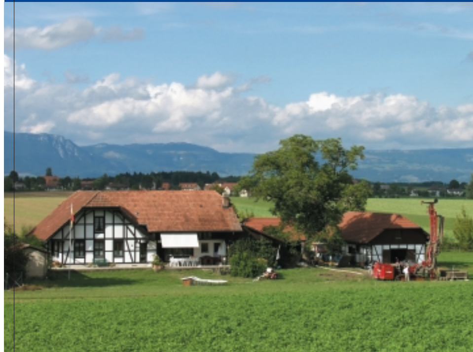
Dieses schöne Berner Bauernwohnhaus wird mit Erdwärme umweltfreundlich beheizt.
