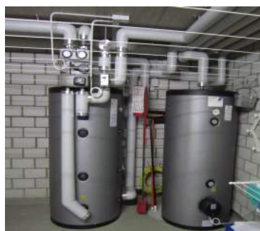
Abb. 4: korrekte Einbindung des Speichers
