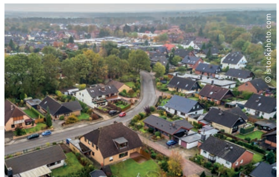
2017 wurden 36 900 Heizungen saniert. 56 000 müssten es sein, um die Energie- und CO 2 -Ziele zu erreichen.
