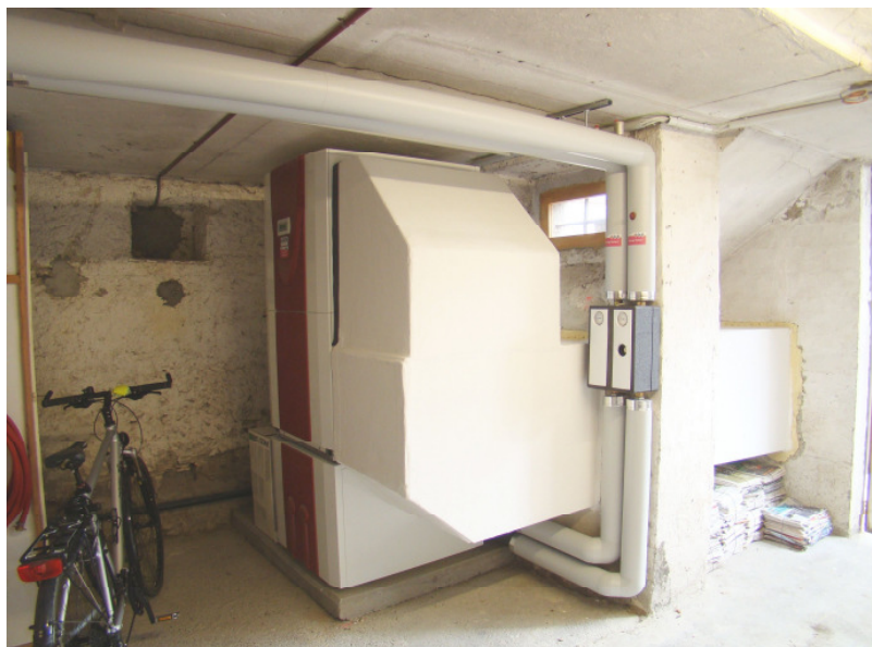
Abb. 4: Anlage 74, LW-WP in einem Altstadthaus eingebaut, Luftansaug- und Ausblasstelle sind gut integriert
