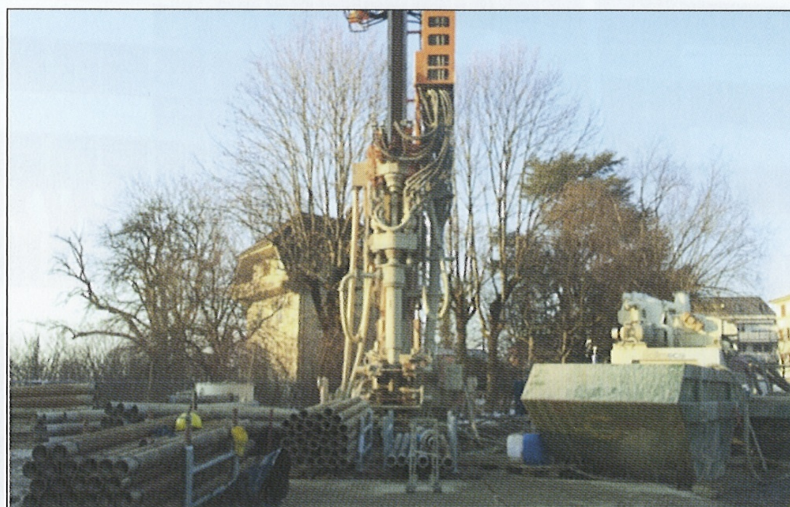
Installation de chantier pour l'implantation d'une sonde géothermique test de 800 mètres de profondeur réalisée en 2015, en vue du projet d'éco-quartier des Plaines du Loup à Lausanne, dont la première étape prévoit l'installation d'environ 35 sondes géothermiques (2018-2020). COPYRIGHT SIL
