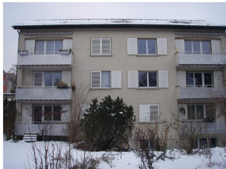
Avant la rénovation
