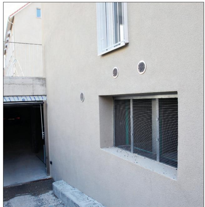
Orifice d'aspiration pour deux pompes à chaleur air/eau avec un débit d'air maximal de  $2 \times 6300 \text{ m}^3/\text{h}$ . Ce type d'exécution, sans grille de protection, se révèle particulièrement silencieux car l'aspiration ne provoque aucune accélération du flux d'air.
