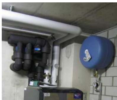
III. 6 : collecteur de sonde géothermique bien isolé
