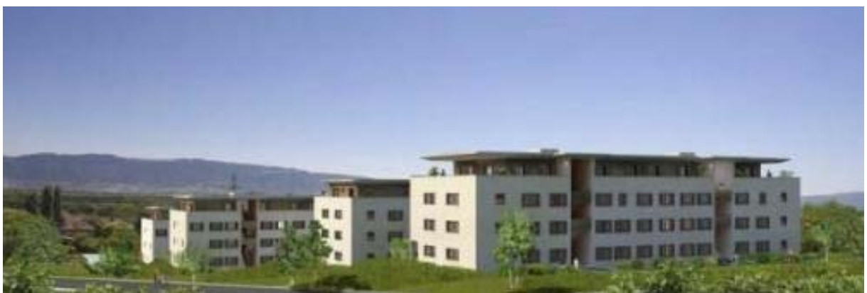
Figure 5: Façades nord de l'ensemble des bâtiments
