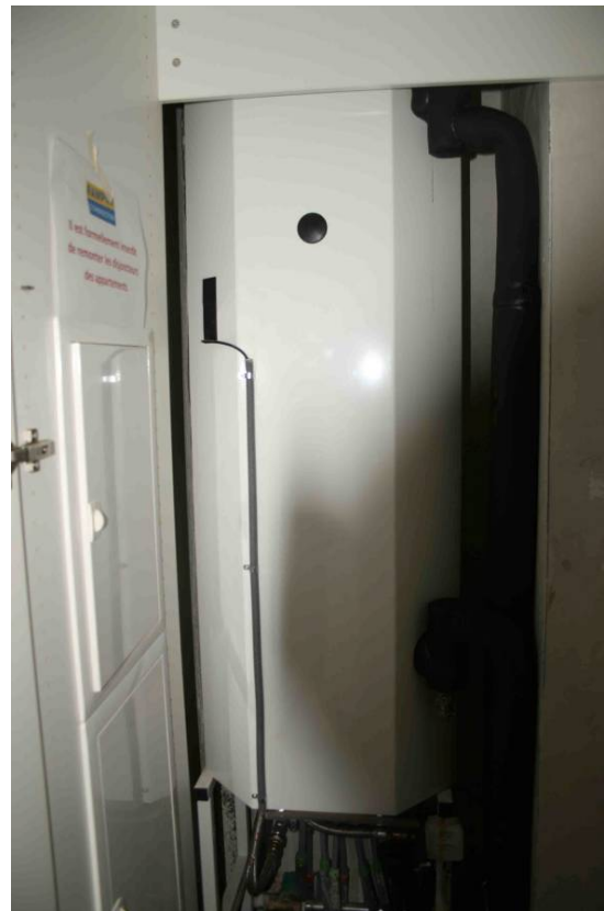
Figure 16 : Boiler individuel de stockage d'eau chaude sanitaire dans un appartement (300 L)
