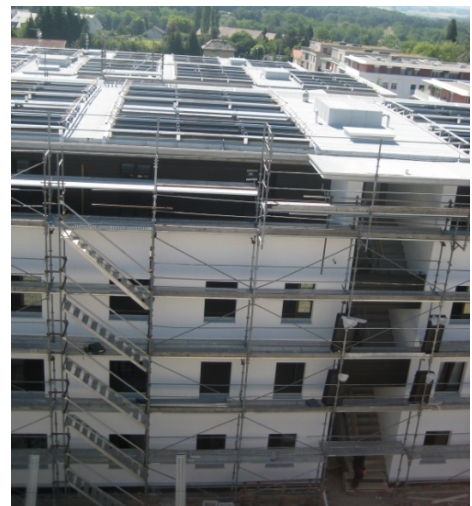
Figure 7: Les Cépages en construction
