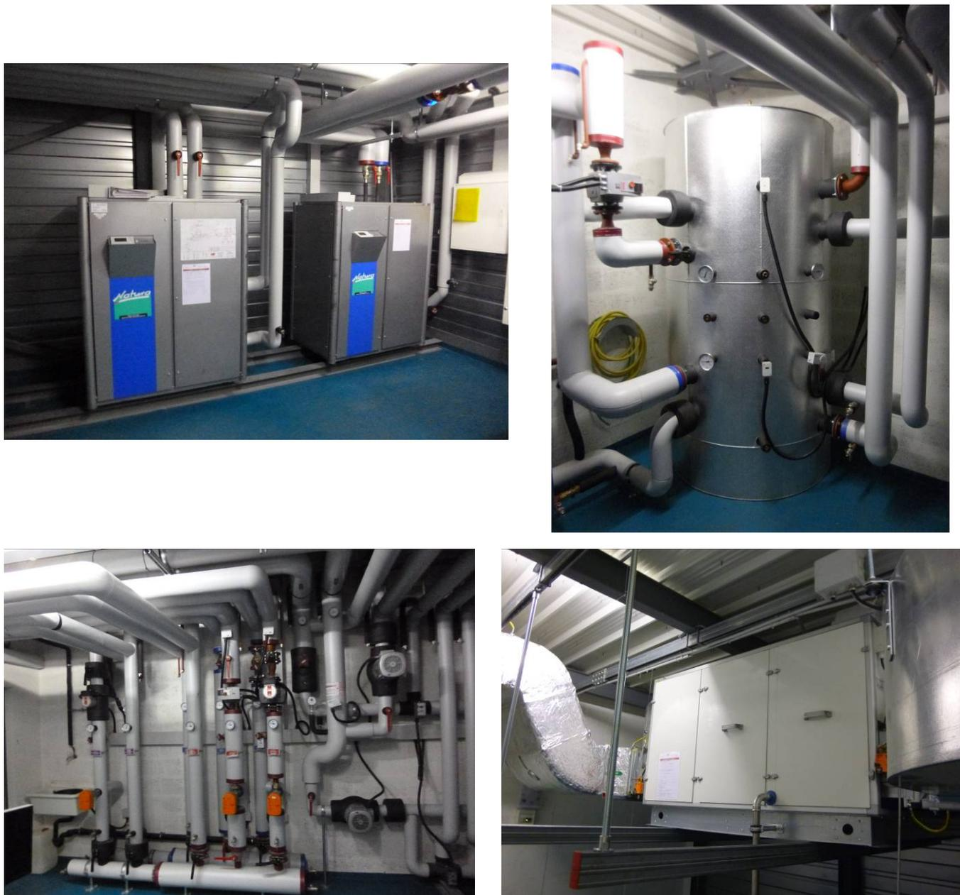
**Figure 17** : Vue des principales installations techniques (de gauche à droite et de haut en bas) : pompes à chaleur, ballon d'accumulation, collecteur et départs de chauffage, monobloc de ventilation
