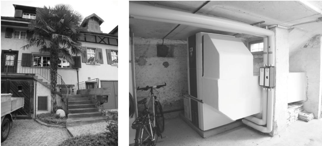
**Abb. 1:** Anlage (LW-WP) in einem Altstadtthaus eingebaut, eine gute Lösung, Luftansaug- und Ausblasstelle sind gut integriert
