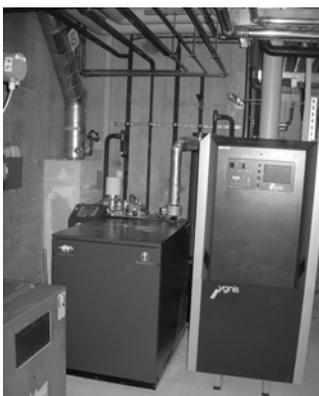
**Image 11 :** *Chaufferie du Collège de la Maladière – Neuchâtel – NE (2003). Le générateur à gaz et la chaudière d'appoint.*
