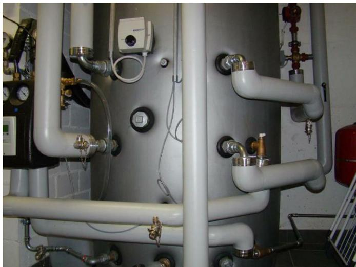
Exemple d'un raccordement hydraulique compliqué qui engendre une perte de l'efficacité énergétique
