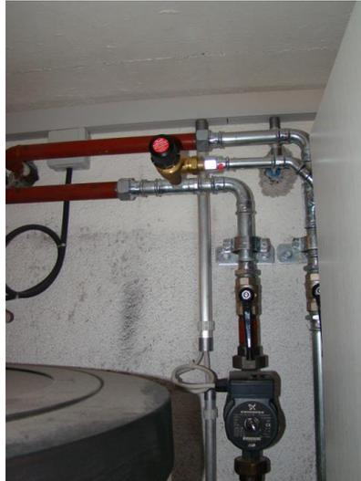
Photos: des exemples de conduites de chauffage non isolées
