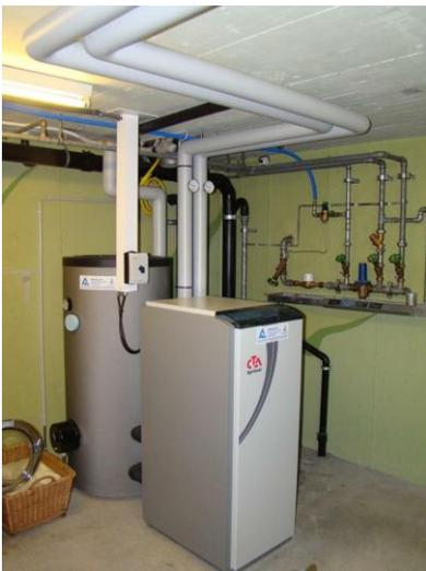
Exemple d'un raccordement hydraulique simple avec bonne efficacité
