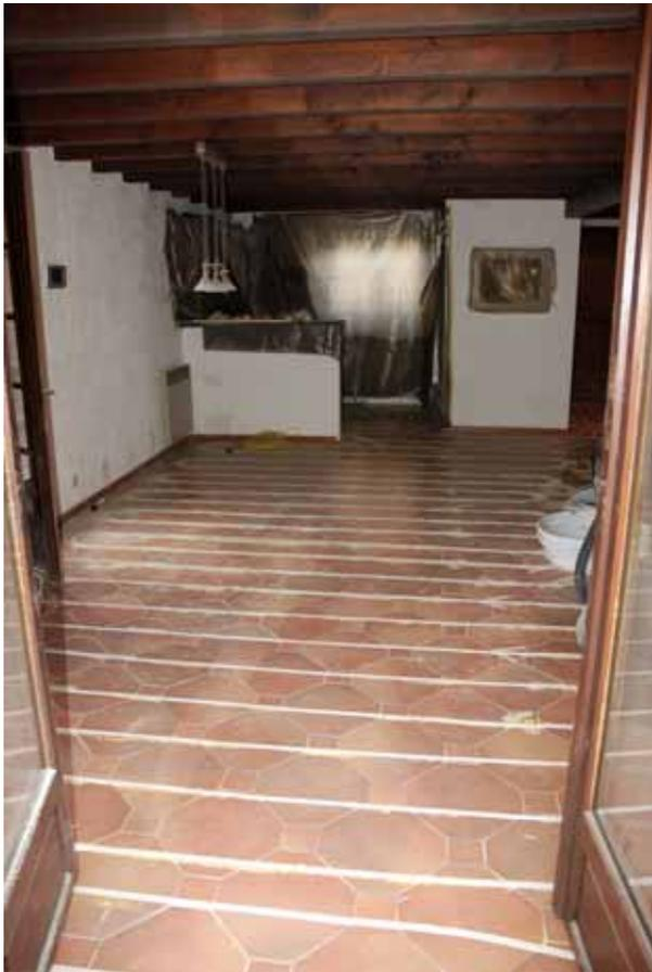
*Des rainures sont aménagées à même le sol. Il suffit ensuite de mettre en place le tuyau de chauffage, de remblayer les rainures avec un mortier sans retrait et de coller un nouveau carrelage. La sur épaisseur n'est de quelques millimètres, celle du nouveau revêtement.*
