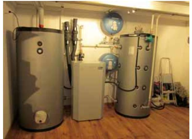
*Le même local que ci-contre aménagé avec la pompe à chaleur sol-eau (sonde géothermique), l'accumulateur et le chauffe-eau. Les tuyaux noirs sont ceux qui arrivent de la sonde géothermique.*
