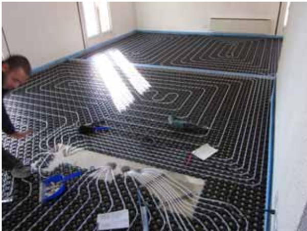
*Après avoir retiré le parquet, le linoléum ou le carrelage, la pose du chauffage au sol préfabriqué peut avoir lieu. Elle peut aussi se faire par-dessus le carrelage existant. Les tuyaux arrivent du sous-sol. On distingue encore le convecteur électrique contre le mur du fond qui sera ensuite retiré.*
