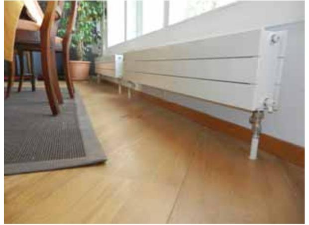
*Détail des mêmes radiateurs que ci-contre. Les liaisons hydrauliques arrivent du sous-sol et sont très discrètes. Le réaménagement est terminé.*
