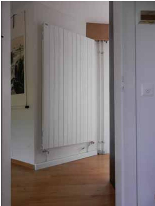
*Ce radiateur hydraulique basse température a remplacé un accumulateur électrique direct. Les tubes passent dans la plinthe blanche sous le radiateur et sont raccordés aux tuyaux verticaux qui vont alimenter un autre radiateur dans une pièce à l'étage.*
