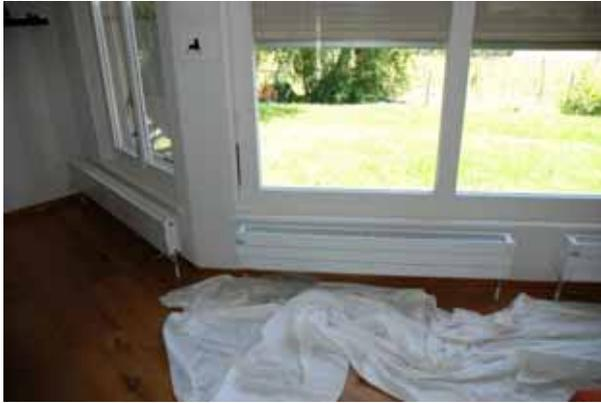
*Ces radiateurs ont remplacés des convecteurs électriques sous des fenêtres. Le chantier n'est pas encore déparassé de sa protection de sol.*
