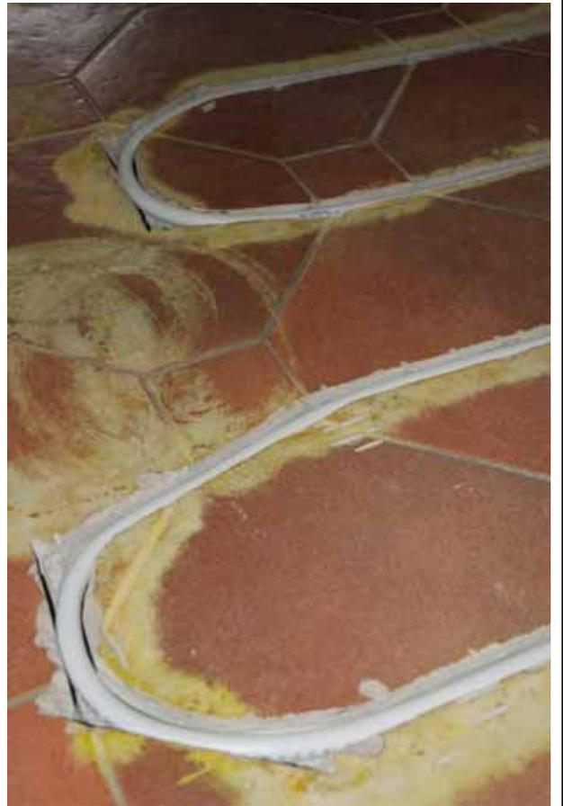
*Ci-dessus, un détail des rainures dans lesquelles un mortier sans retrait sera coulé. Ensuite, un nouveau revêtement de sol peut être mis en place. Ce type de chauffage au sol peut se faire sans sur épaisseur pour autant que le vieux carrelage soit retiré.*
