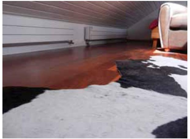
*La même pièce aménagée avec des radiateurs hydrauliques basses températures. Les liaisons hydrauliques sont cachées dans un canal sous les radiateurs et au-dessus du plancher.*
