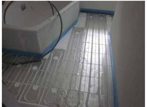
*Ci-dessus un autre type de chauffage eau sol préfabriqué. Les tuyaux sont insérés dans des rainures incrustées dans l'isolation et dans des plaques d'aluminium qui vont permettre de répartir la chaleur. Il ne restera qu'à coller le carrelage. Epaisseur totale 30 mm. Le propriétaire profite de ces travaux pour remplacer sa baignoire*
