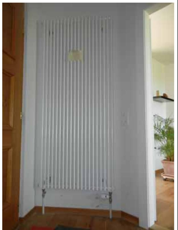
*Le convecteur électrique ci-contre à gauche a été remplacé par un radiateur hydraulique à basse température. Les liaisons hydrauliques arrivent directement du sous-sol.*
