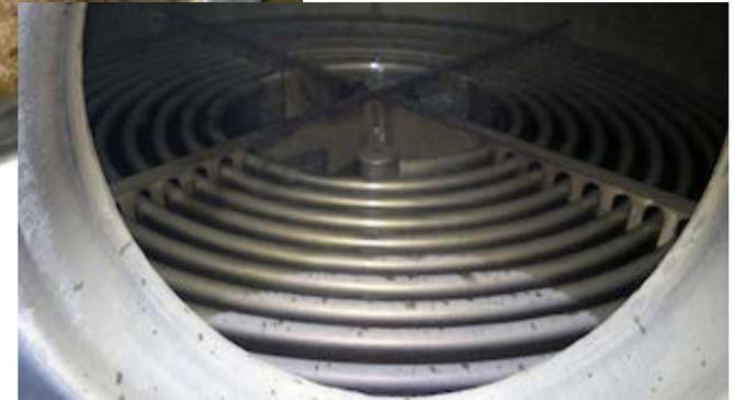
Je härter das Wasser und je stärker es erhitzt wird, umso öfter sollte der Trinkwarmwasserspeicher (ugs: Boiler) entkalkt werden
