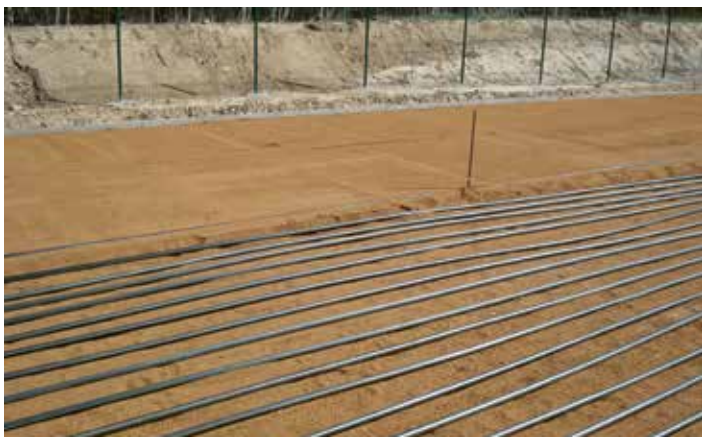
Abbildung 4.10: Neuanlage eines Erdwärmeregisters. Dieses wird anschliessend wieder mit Erdreich überdeckt (Quelle: HakaGerodur).
