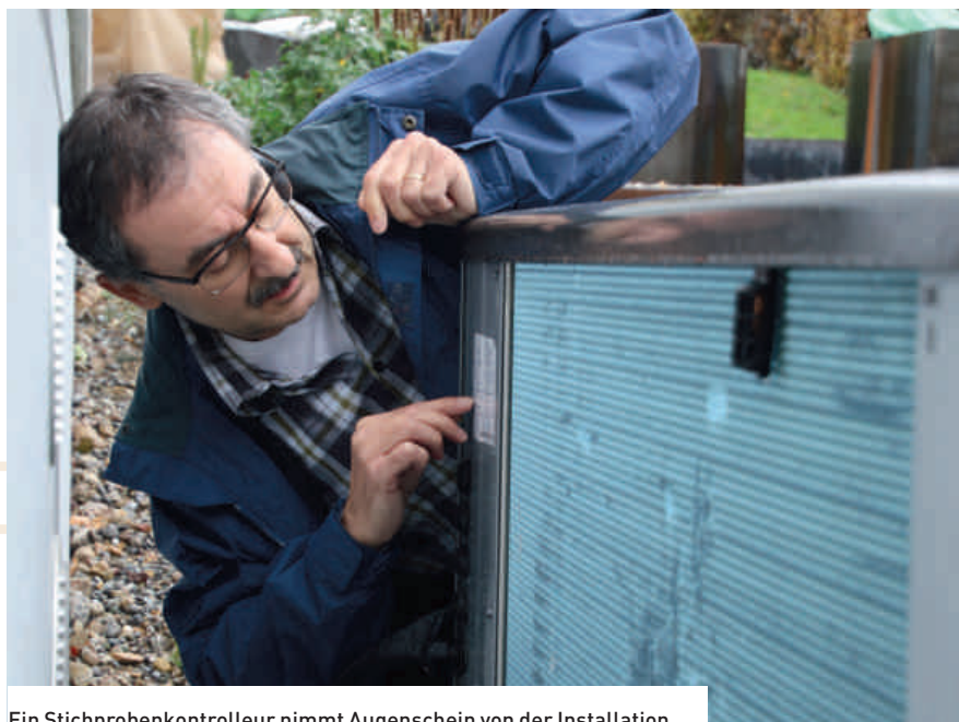
Ein Stichprobenkontrolleur nimmt Augenschein von der Installation. Auch das Datenblatt wird kontrolliert.
