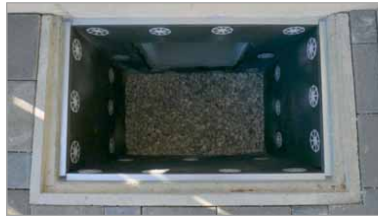
Stufe 2 - Auskleidung Lichtschacht
