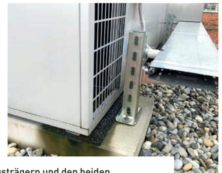
Die Schallentkopplung zwischen den Befestigungsträgern und den beiden Wärmepumpen, sowie beim Elektroanschluss wurden leider ungenügend ausgeführt. Dies führt unweigerlich zu Körperschallübertragungen auf den Baukörper.
