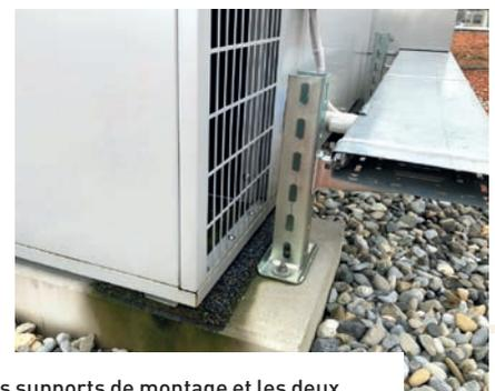
Malheureusement, l'isolation acoustique entre les supports de montage et les deux pompes à chaleur, ainsi qu'avec le raccordement électrique, est insuffisante. Cela conduit inévitablement à une transmission des bruits de structure au corps du bâtiment.
