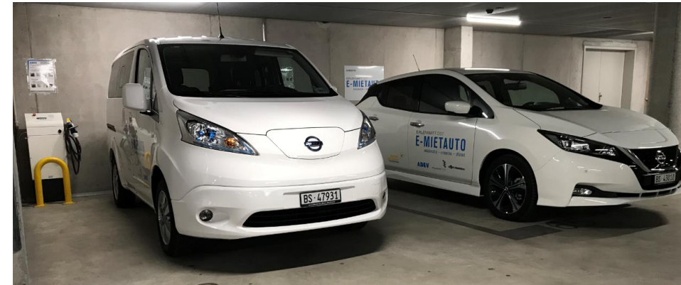
Erlenmatt Ost Areal mit 13 MFH, 650 kWp PV, 2 zentrale WPs, 2 bidirektionale Ladestationen, ZEV
