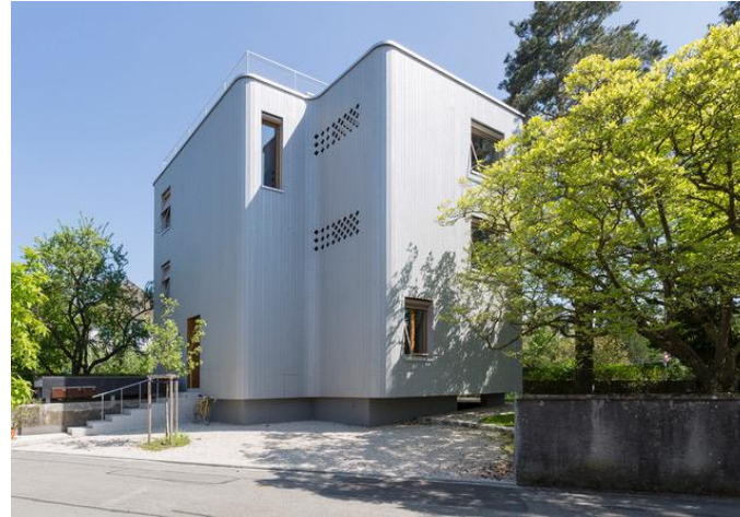
Wettingen MFH, Taktende WP mit Sonde Minergie-Monitoring, ZEV
