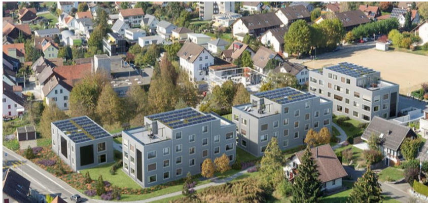
Möriken-Wildegg Areal mit 4 MFH, Taktende WP mit Sonde, passive Kühlung im Sommer, vorbereitet für 20xEmobile, Fassaden-PV, Gebäude als Speicher, ZEV
