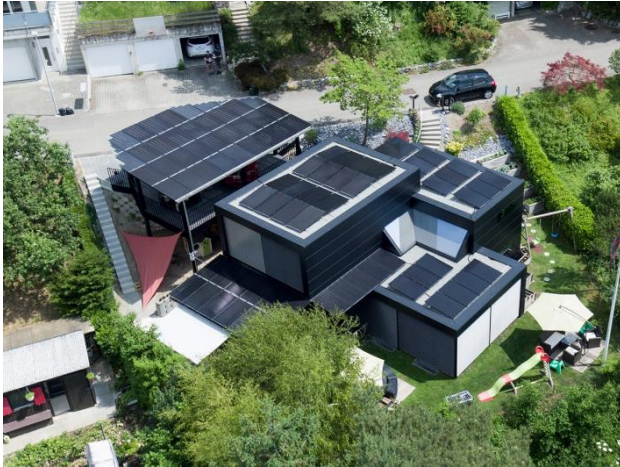
Remigen EFH, Inverter-WP mit aktiver Kühlung im Sommer, 2xEmobile, Batteriespeicher
