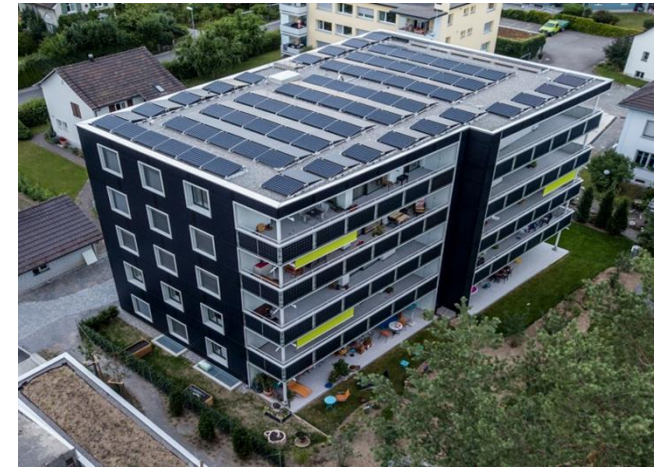
Wetzikon MFH, Taktende WP mit Sonde, passive Kühlung im Sommer, 4xEmobile, Car-Sharing, Fassaden-PV, Batteriespeicher, ZEV
