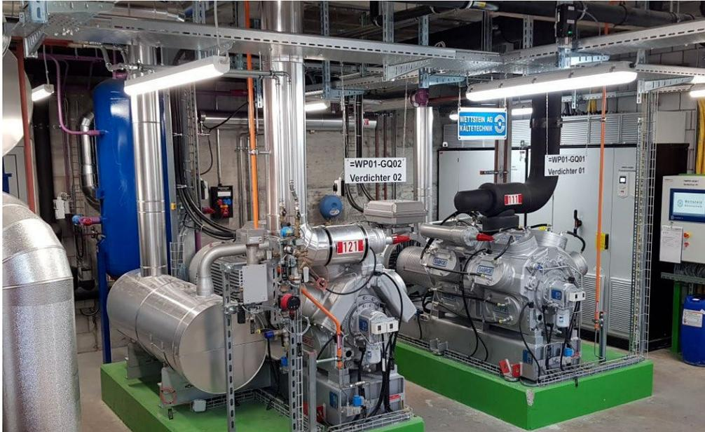
2-Stufige **Ammoniak**-Wärmepumpe mit offenem Zwischenkühler. Wärmeverbund Wohlen Bern
