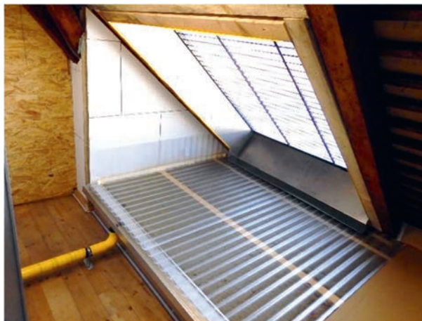
Abbildung 6: Einbringung einer Wärmepumpe (links) und Luft-Ausblasnische beider Wärmepumpen
