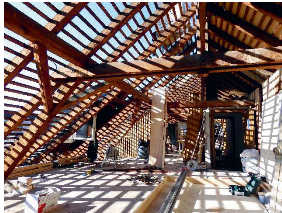
Abbildung 5: Betonfundamente für WP-Aufstellung (links) und Dach nach Abbruch der Kamine und Entfernung der Ziegel (rechts)
