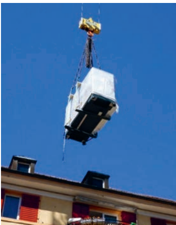
Abbildung 6: Einbringung einer Wärmepumpe (links) und Luft-Ausblasnische beider Wärmepumpen
