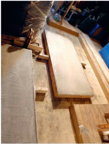
Abbildung 5: Betonfundamente für WP-Aufstellung (links) und Dach nach Abbruch der Kamine und Entfernung der Ziegel (rechts)
