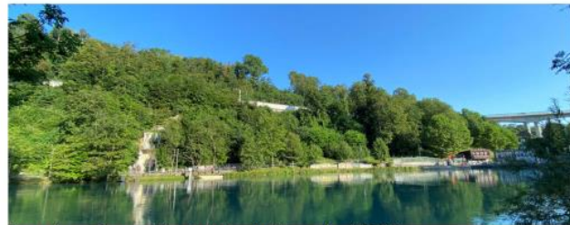
Fassungsbauwerk aussen nicht wahrnehmbar, Ansicht vor und nach Realisierung
